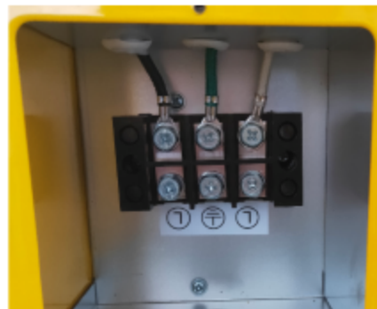
Figura 10 - Al retirar la cubierta del cableado se exponen los cables. Al conectar a tierra un cable de 2 conductores, el cable blanco debe marcarse como negro.
